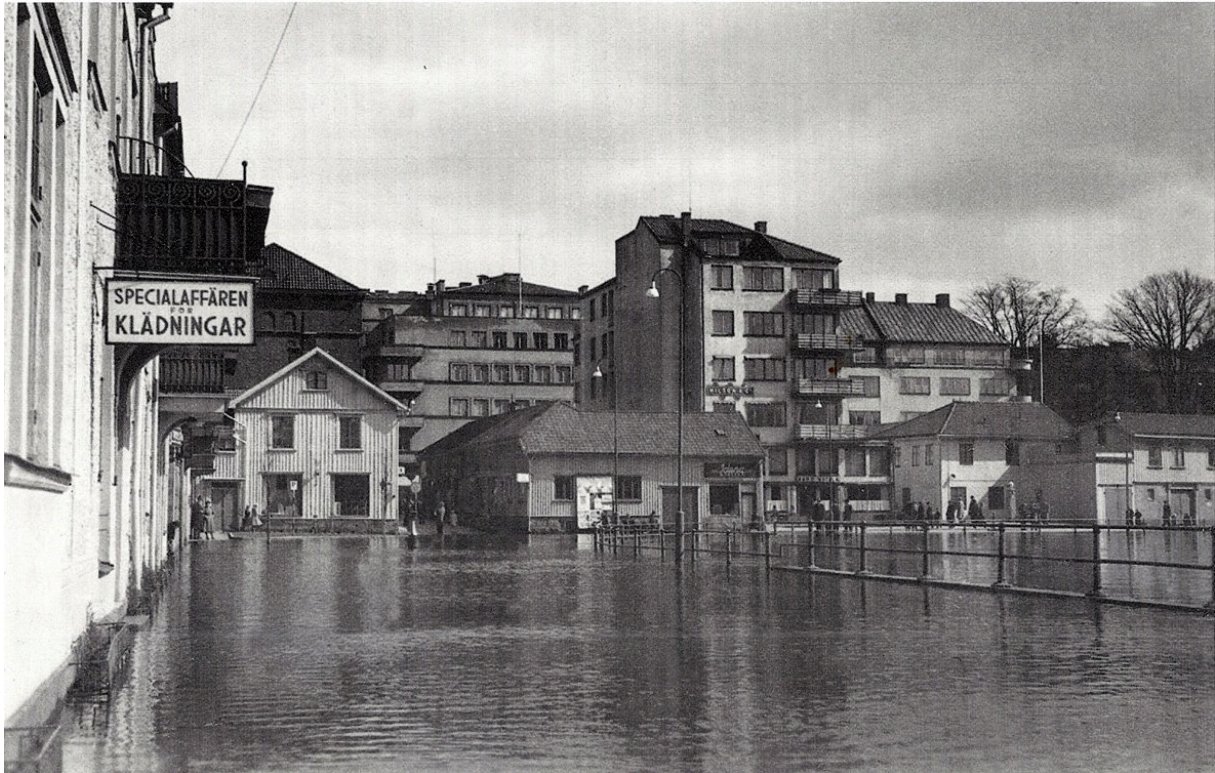
Viskans Översvämning 1951 Södra Strandgatan
