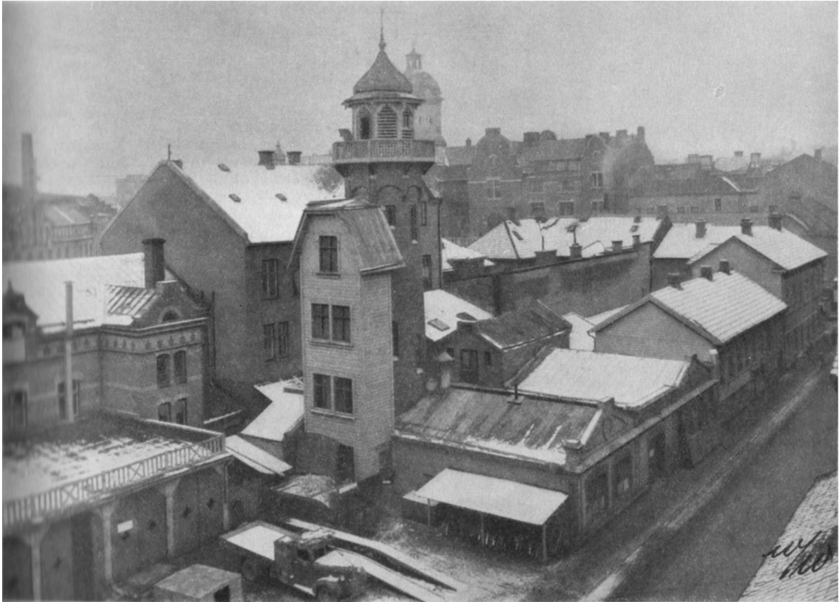
Borås gamla brandstation
