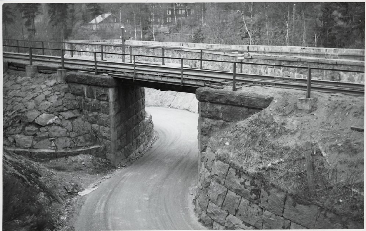
Järnvägsviadukten i Viskafors Del 1 (2)
