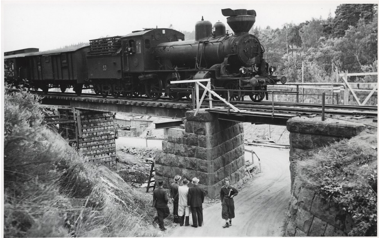
Järnvägsviadukten i Viskafors Del 2 (2)
