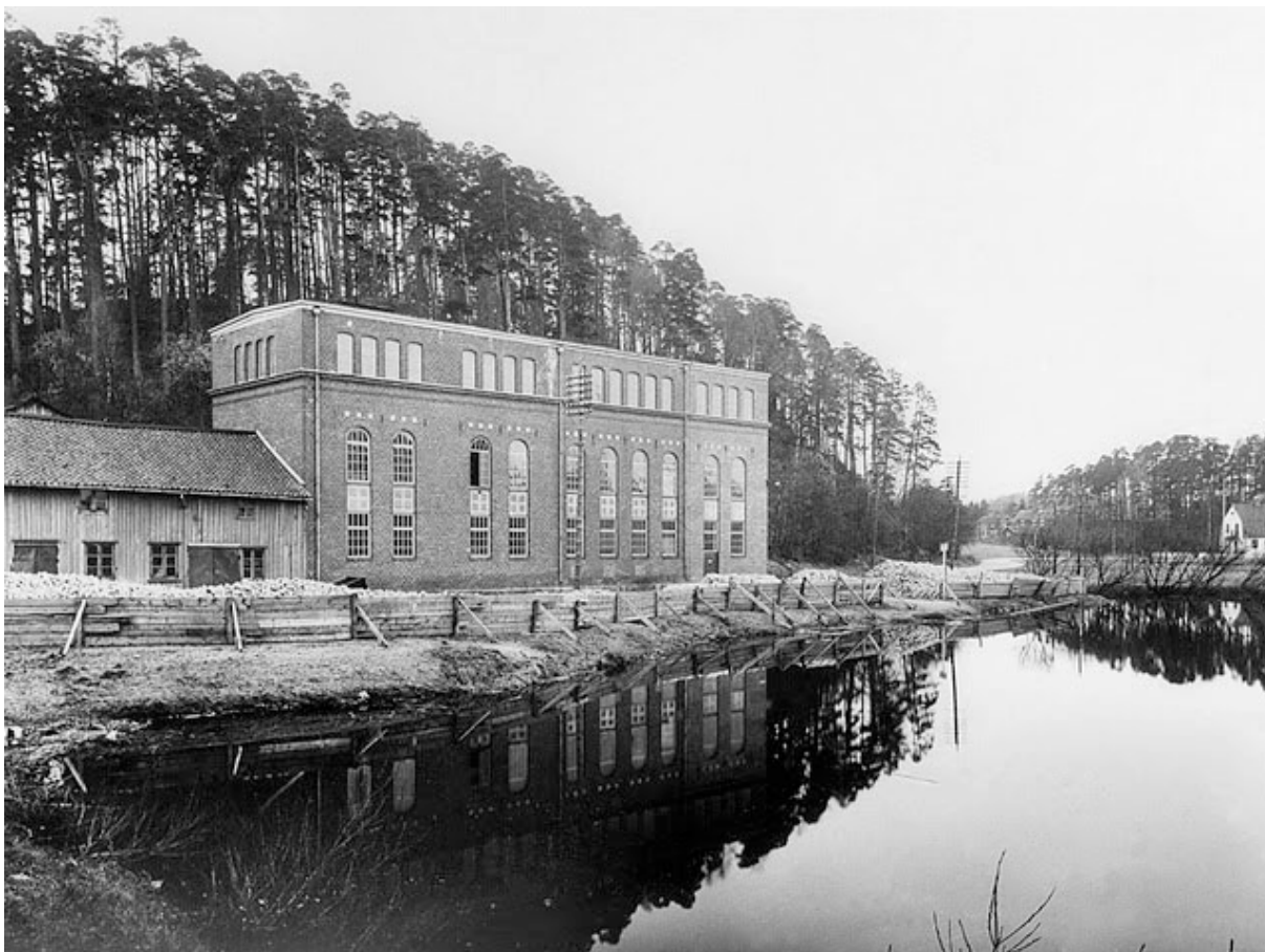
Transformatorstation vid Bockasjön
