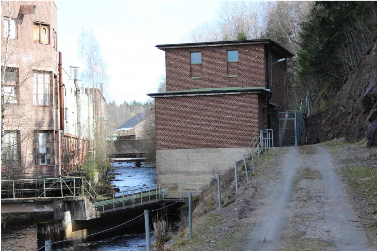
Foto Glenn Murberg 20160414 Rydboholms Kraftstation 1 (2)
