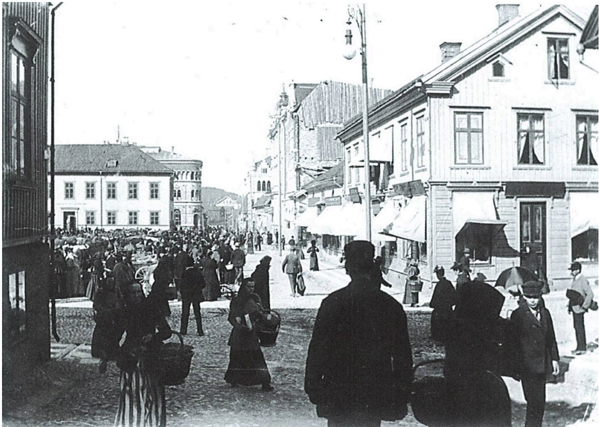
Torgatan Mot Väster
