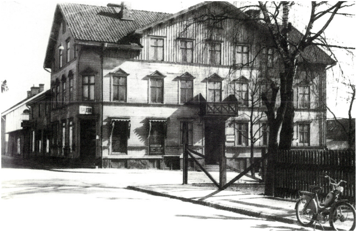
Korsningen Norrby Tvärgata - Norrby Långgata.
