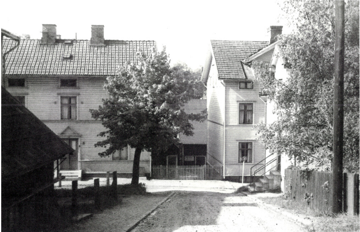
Nedre delen av Skogsbackegatan mot Billdalsgatan
