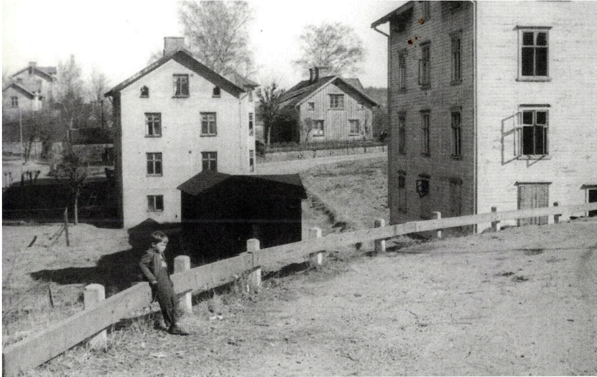
Nedre Viskadalsgatan med utsikt mot Bildalsgatan
