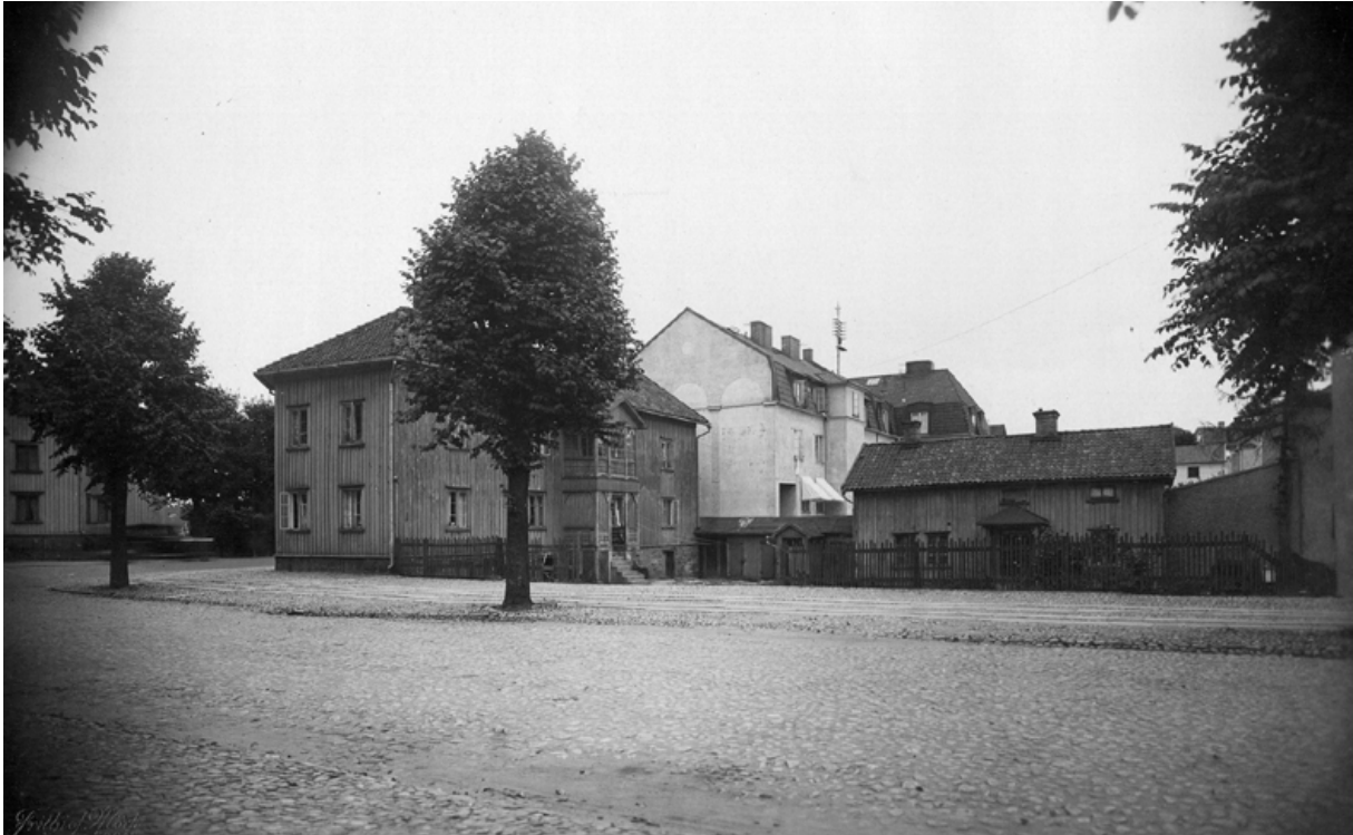
Kungsgatan Kv. Bifrost
