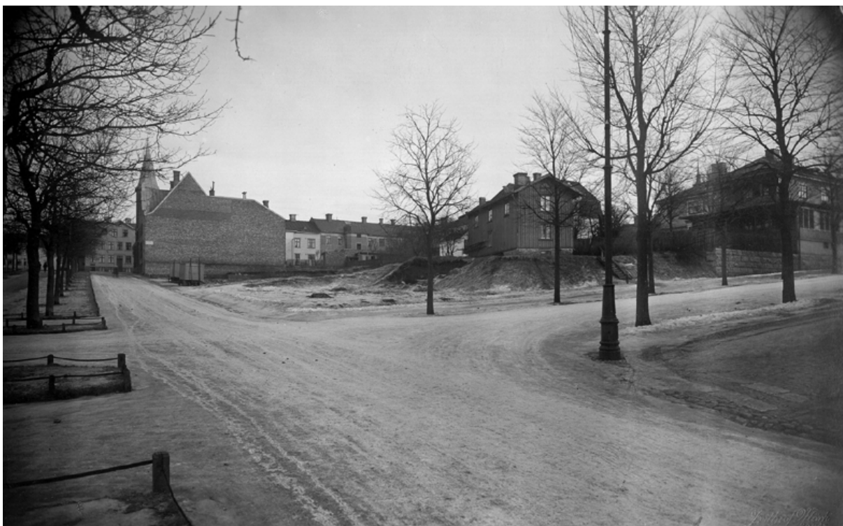
Korsningen Yxhammarsgatan - Kungsgatan
